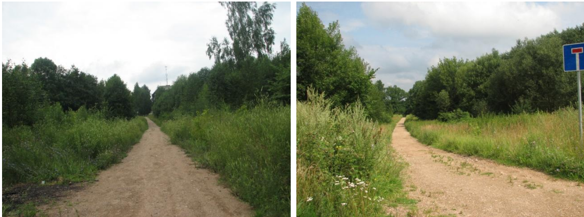
2.8.4 pav. Nesutvarkytas ir apleistas keliukas vedantis į vienintelę esantį kultūros paveldo objektą Rukloje (Ruklos piliakalnis)
